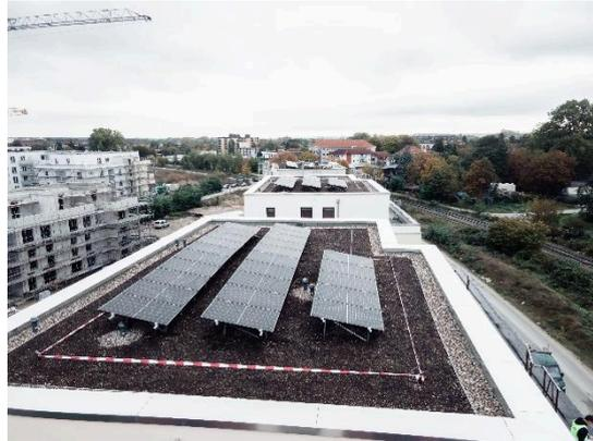
Die Besonderheit bei den Anlagen der Wiederaufbau ist die Kombination aus Gründach und PV-Anlage. Damit setzen diese Immobilien ein besonderes Zeichen in Sachen Nachhaltigkeit.
